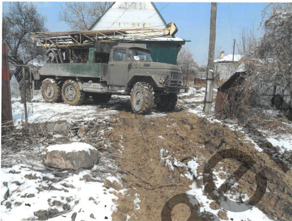
Рисунок 5. Скважина-2. Подготовка к буровым работам (расположение буровой установки).
