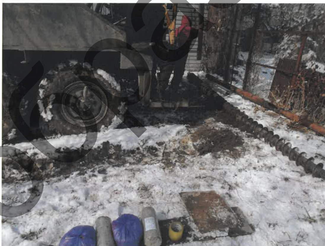
Рисунок 4. Скважина-1. Подготовленные к отправке в лабораторию пробы нарушенной и не нарушенной структуры.
