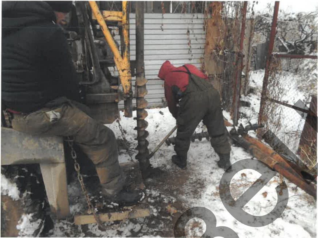
Рисунок 1. Скважина-1. Ведутся буровые работы.
